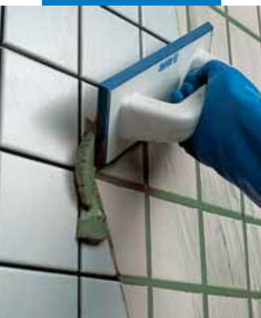
Заполнение швов на стене составом Ultracolor Plus с помощью резинового шпателя
