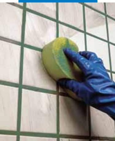
Окончательная очистка плитки с помощью губки
