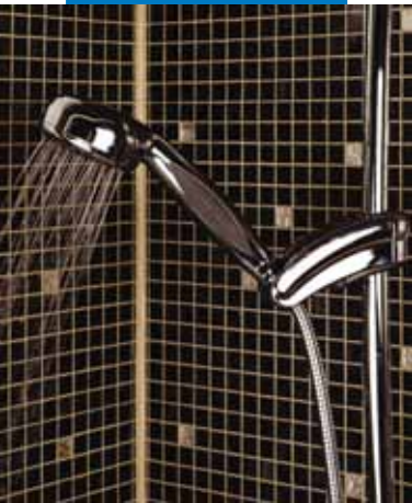
Пример заполнения швов стекломозаики составом Ultracolor Plus в душевой кабине
